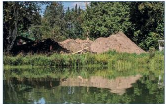
Exemple à ne pas reproduire lors de travaux à la maison. Crédit photo : COBALI
